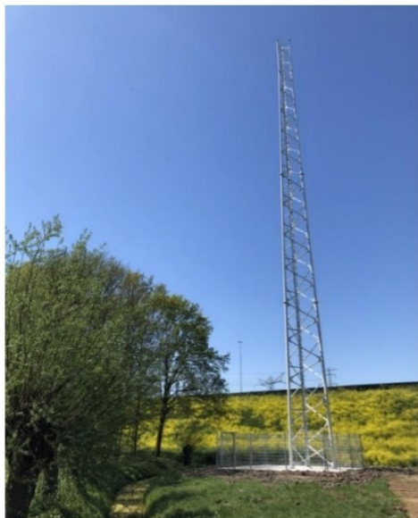
Afbeelding 3: Telecom-vakwerkmast(40 meter)
