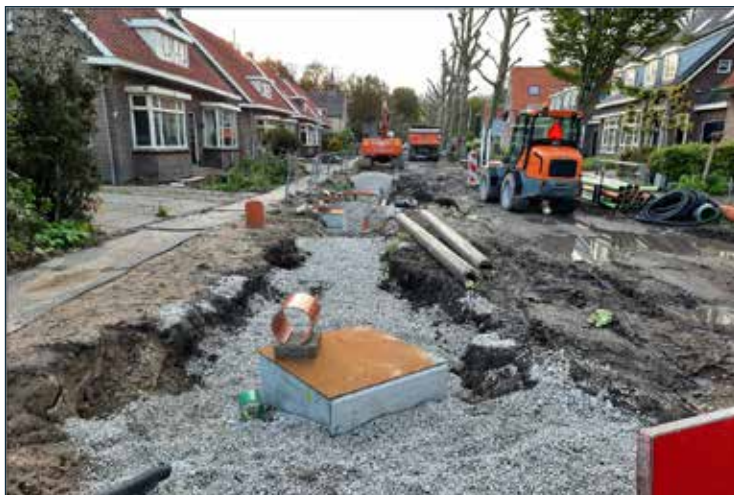
Afbeelding 4-2. Vervanging van het riool
