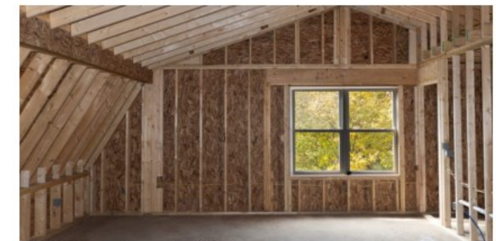
HSB opbouw (lichte bouwconstructie)
