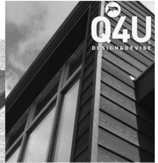
Rabat of potdeksel buitengevel met robuuste hoekprofielen
