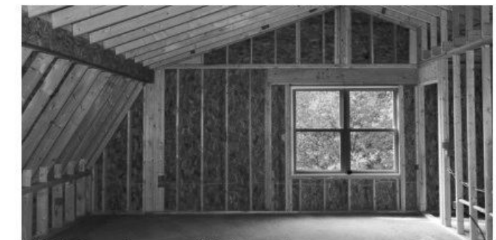
HSB opbouw (lichte bouwconstructie)
