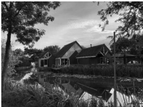
Bestaande aanzicht vanaf het water
