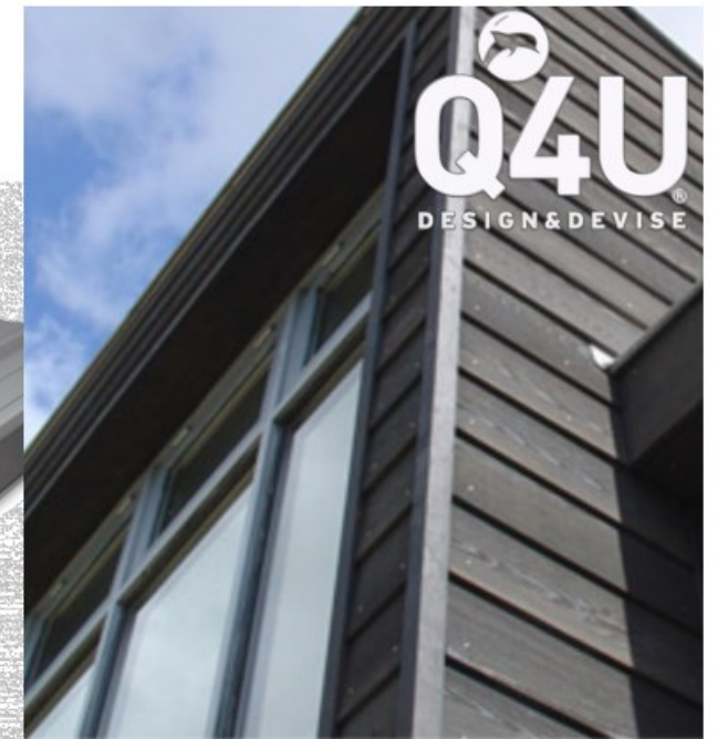
Rabat of potdeksel buitengevel met robuuste hoekprofielen
