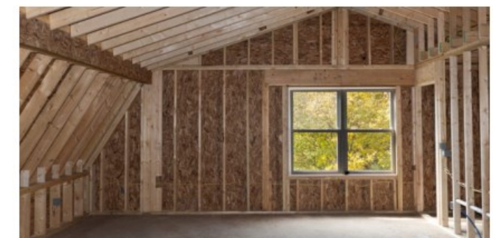
HSB opbouw (lichte bouwconstructie)
