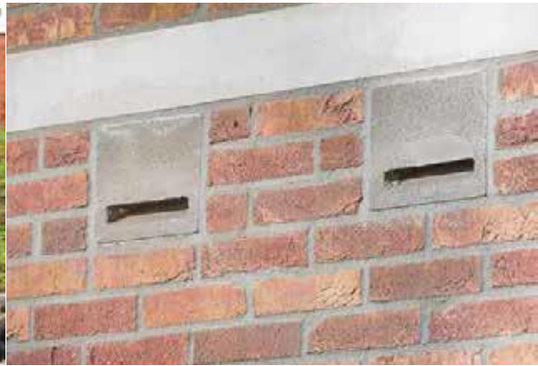
Toepassen van vleermuiskasten in de gevel
