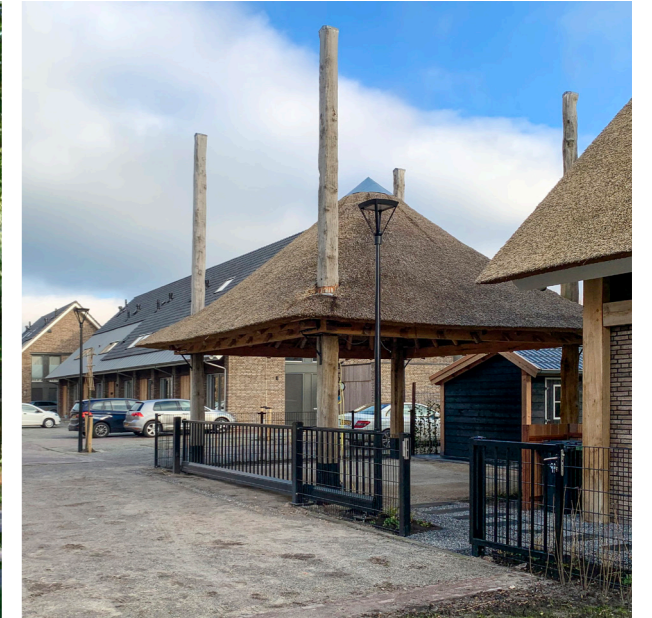
Hooischuur tpv elektriciteitshuis/gezamenlijke berging
